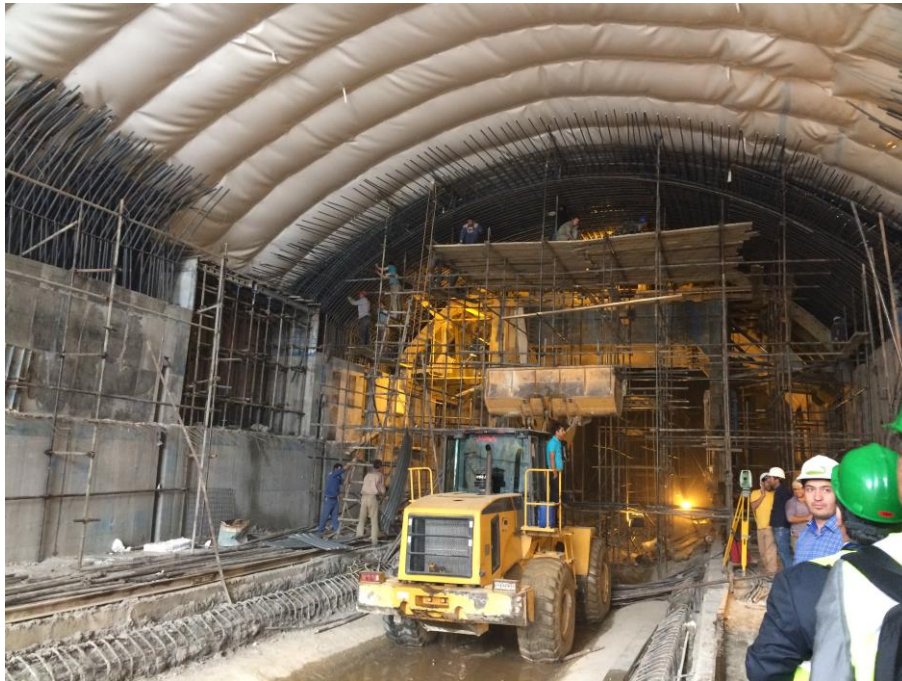
Travaux sur la ligne 2 du métro de Mashhad
