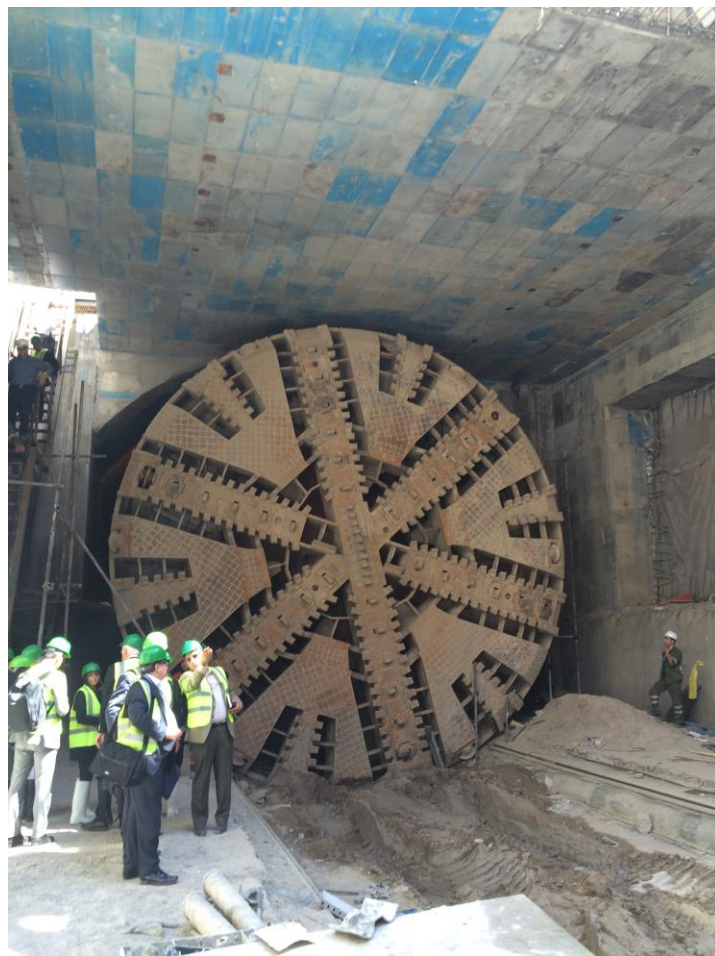
Tunnelier utilisé pour les travaux de la ligne 2 du métro de Mashhad
