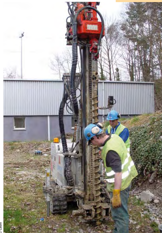
Sondage à la tarière pour la reconnaissance des sols
