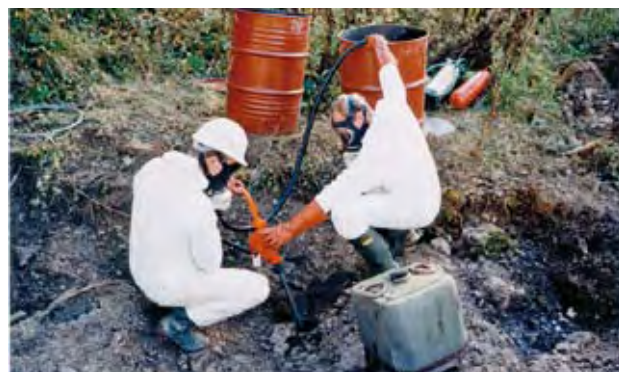
Les techniciens vident à l'aide d'une pompe à main la substance stockée dans un fût enterré avant qu'il ne soit extrait du sol à la pelle mécanique
