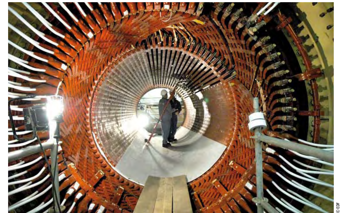
Alternateur dans une centrale nucléaire (EDF)
