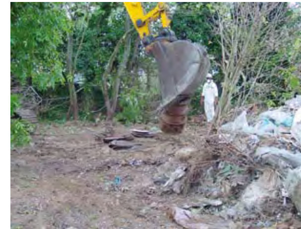
Des déchets enfouis dans le sol sont excavés à la pelle mécanique et compressés
